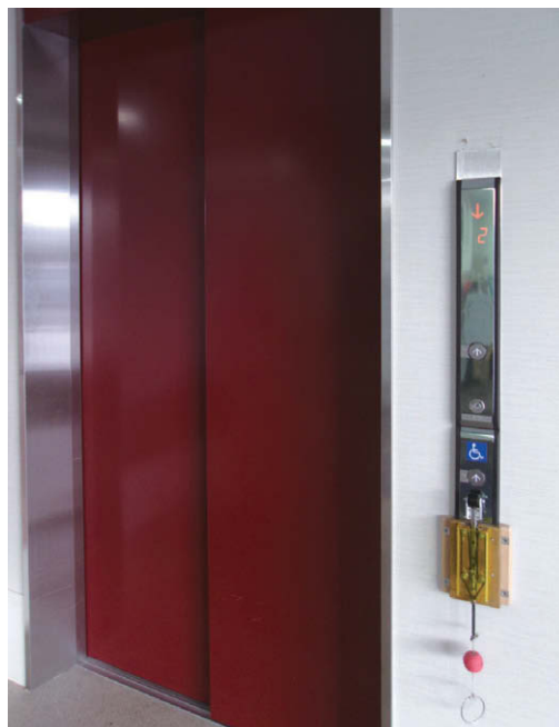
エレベータ概観 (押しボタン下に自助具を設置した様子)
